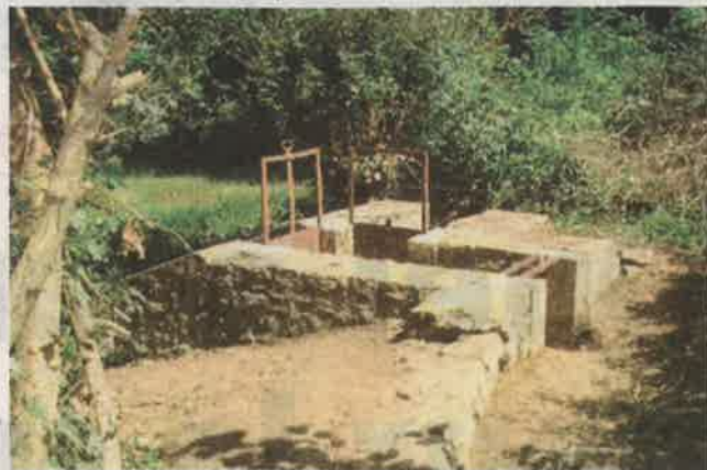
Vanne martelière du sentier de Gleizé.
